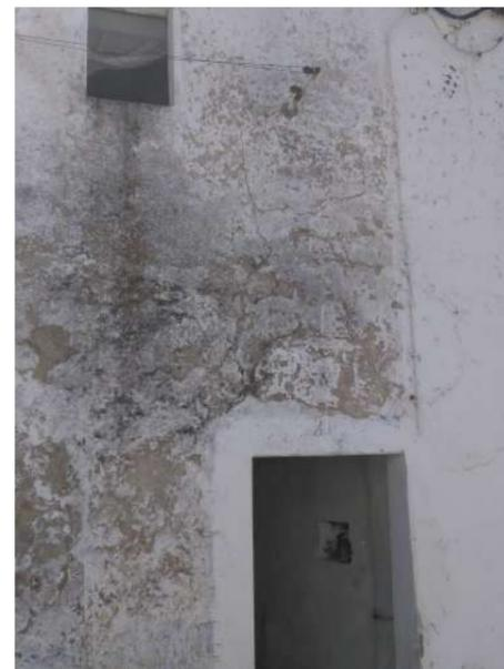
O aparecimento de fissuras pode ainda resultar de uma deformação do próprio edifício, podendo estas tensões ser transferidas para os materiais de revestimento, refletindo-se numa desagregação das argamassas. Tal como mostra o gráfico 77, cerca de 30,4% dos edifícios já apresenta esta patologia nas suas fachadas.
