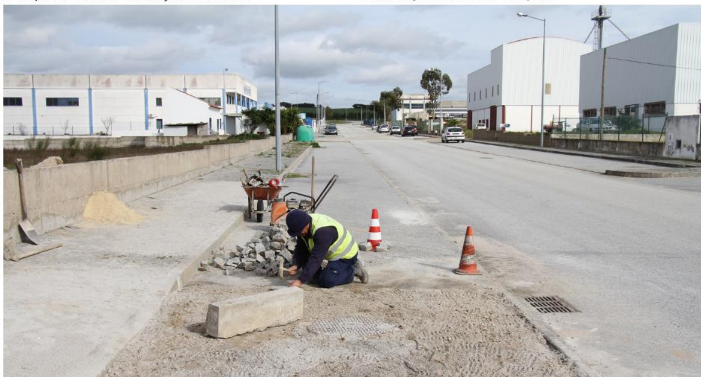
4 - Zona Industrial de Arraiolos - Manutenção de piso
