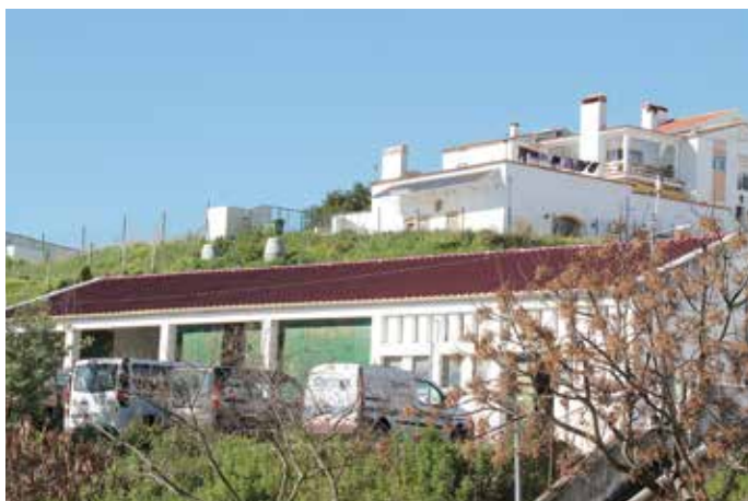
▶ ESTALEIRO MUNICIPAL SUBSTITUIÇÃO DE TELHADO
