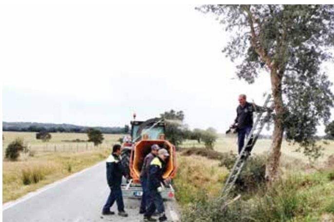
▶ LIMPEZA DE ÁRVORES
