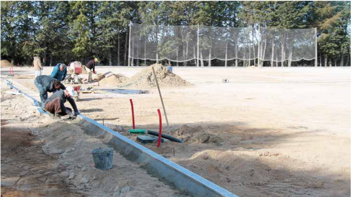
▶ OBRAS DE BENEFICIAÇÃO, RELVADO SINTÉTICO, DO CAMPO GOMES CALLADO APOIO CÂMARA MUNICIPAL DE ARRAIOLOS
