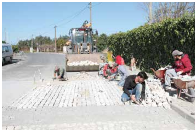
▶ RUA VASCO DA GAMA COLOCAÇÃO DE PASSADEIRA ELEVADA
