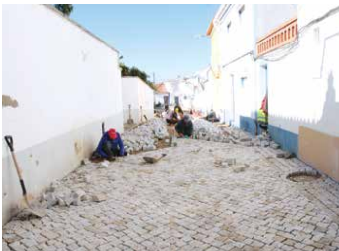
▶ RUA DO MONTINHO ARRUAMENTOS
