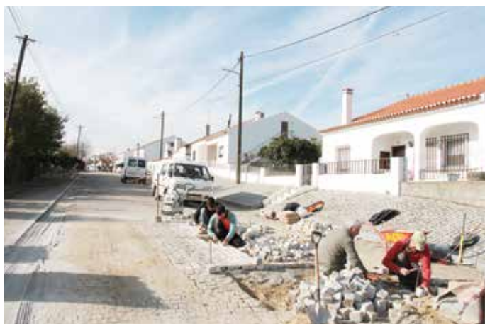
▶ RUA DE ÉVORA COLOCAÇÃO DE PASSADEIRA ELEVADA
