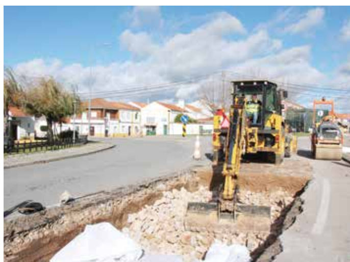
▶ ENTRADA VIMIEIRO N. 4 SANEAMENTO E PAVIMENTAÇÃO
