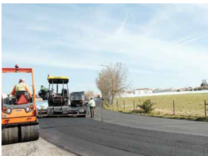
▶ BENEFICIAÇÃO DE ESTRADA JUNTO AO CEMITÉRIO SANEAMENTO E PAVIMENTAÇÃO
