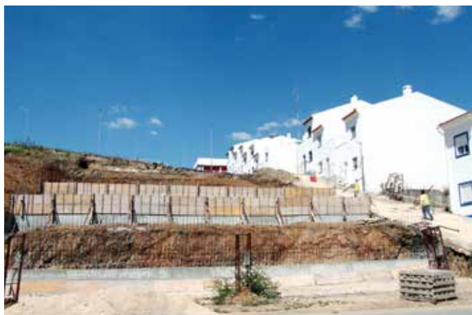
▶ BAIRRO CRUZ DA BARRETA CONSTRUÇÃO DE MURO DE SUPORTE
