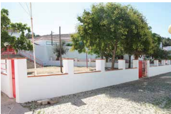
▶ PISCINAS MUNICIPAIS MANUTENÇÃO E PINTURA
