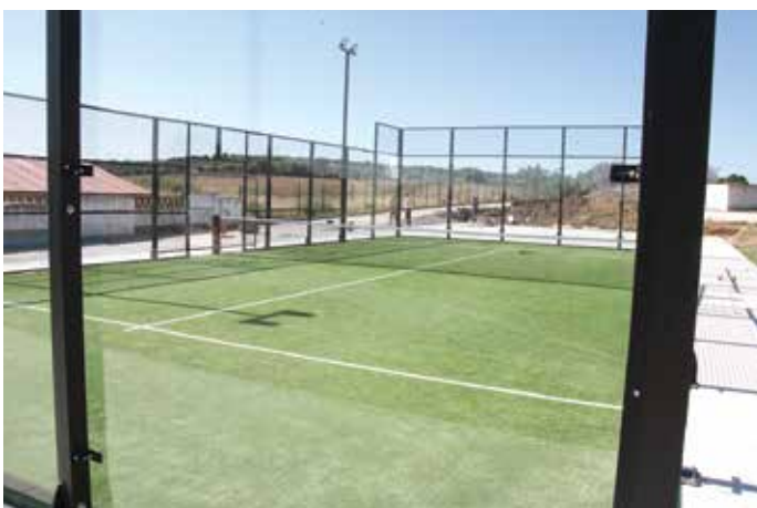
▶ CAMPO DE PADEL CONSTRUÇÃO
