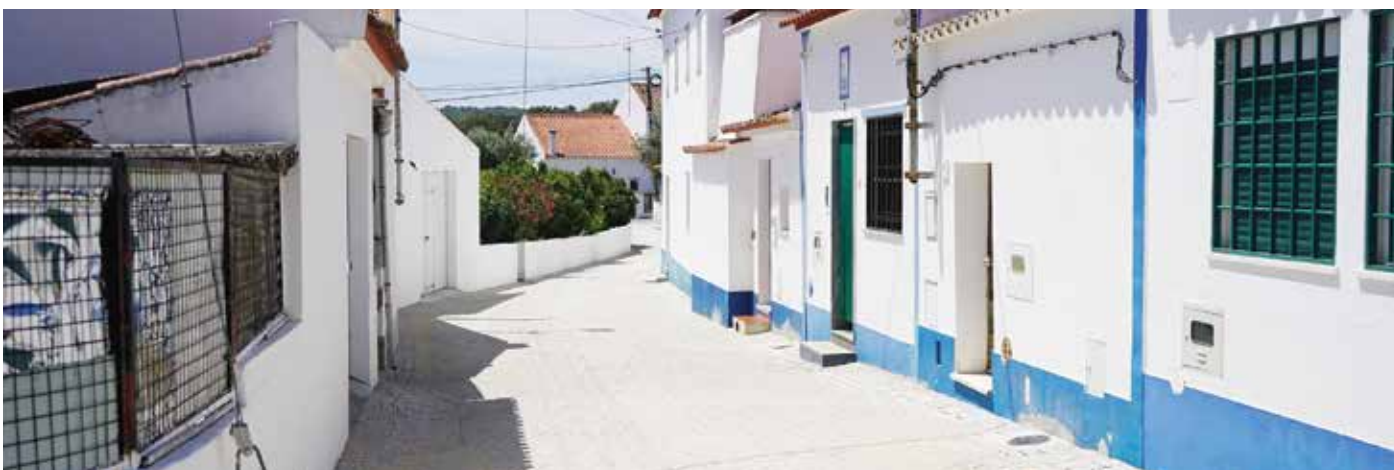
▶ ARRANJOS CONCLUSÃO DA OBRA DE CALCETAMENTO NA TRAVESSA 28 DE SETEMBRO E RUA ANTÓNIO JOSÉ FREIXO POMBINHO
